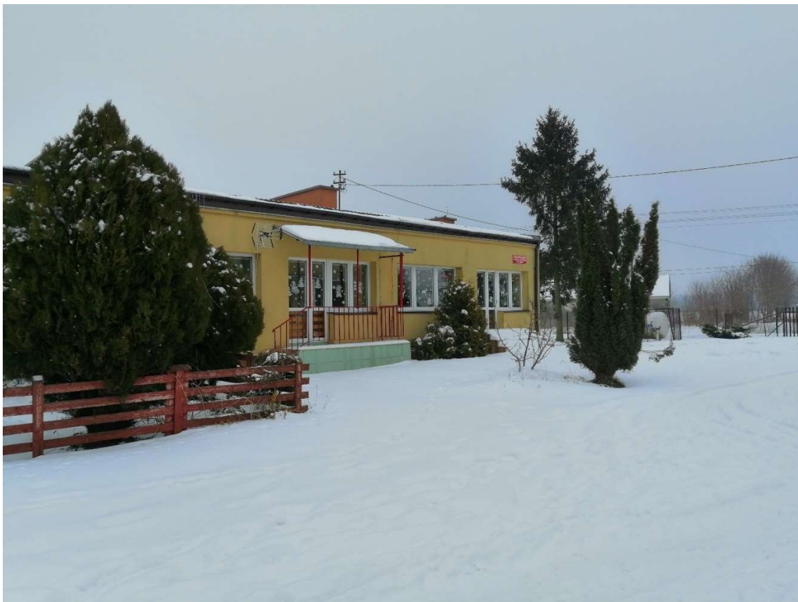
Rys. 18. Elewacja frontowa budynku
