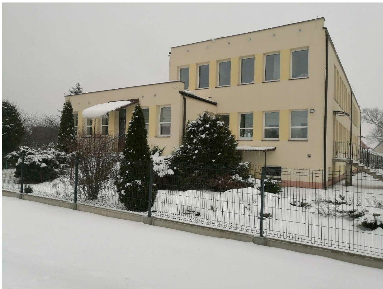
Rys. 7. Elewacja frontowa budynku
