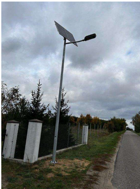
Przykłady zamontowanych lamp solarnych na terenie Gminy Radzanów
