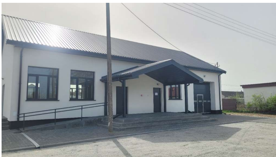
Modernizacja w budynku świetlicy wiejskiej we Wróblewie
