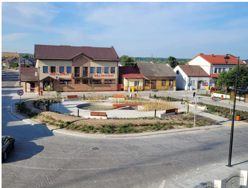
Modernizacja Placu Piłsudskiego
